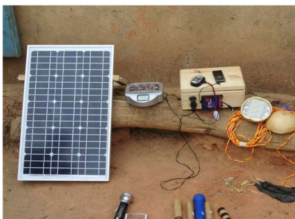
Bestandteile eines Solar-Home-Systems
