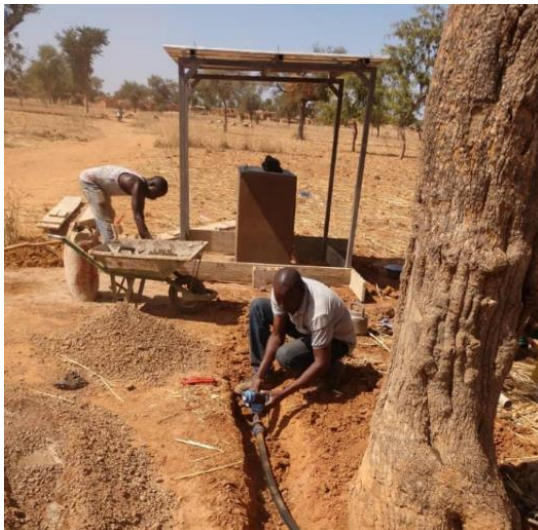
Bilder der Brunnenbaustellen in Tampoaga und Badinogo II
