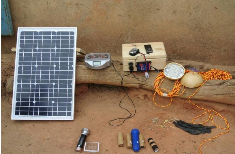
Bestandteile eines Solar-Home-Systems
