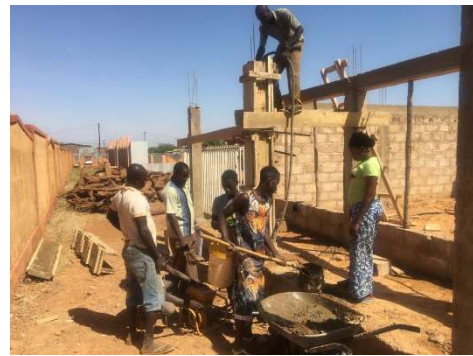
Bau des Infozentrums. Mit dabei: 3 Auszubildende des CFPK
