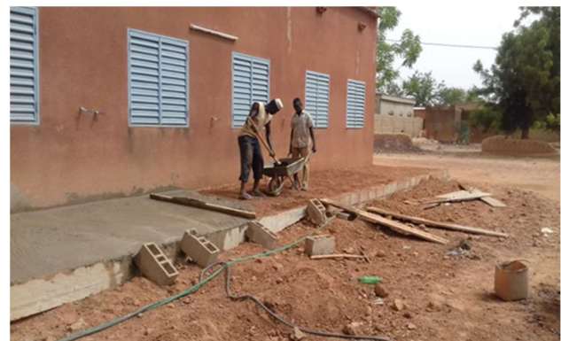
Hinter der Schule ist das neue Fundament fast fertig
