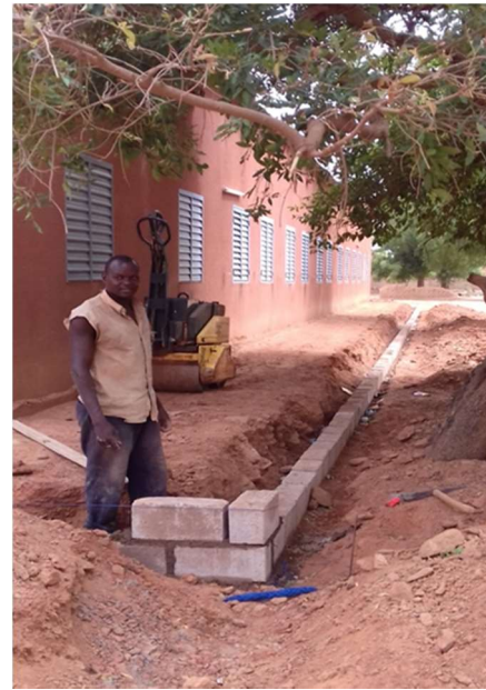
Die Arbeiten haben begonnen
