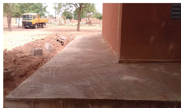
Und so sieht das neue Fundament jetzt aus.
