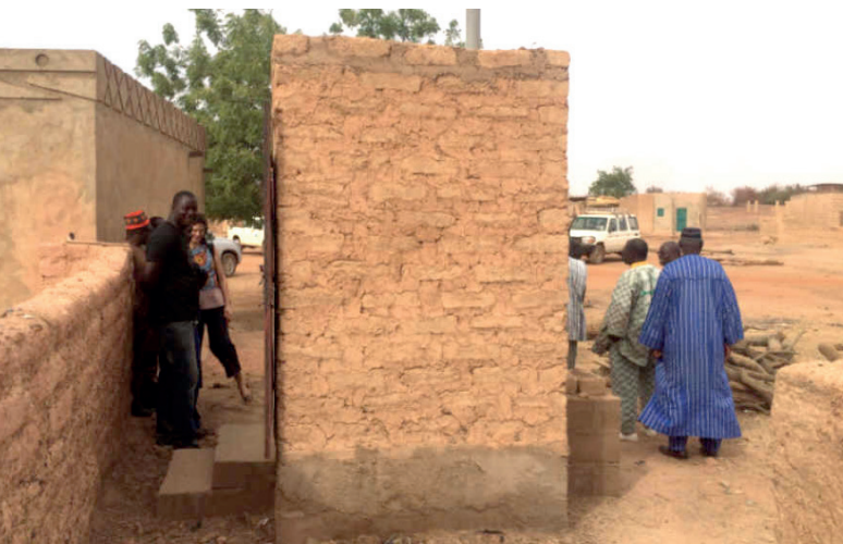
Latrine von außen ...
